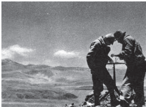
Empezamos a esbozar el mapa... Mediciones de acimut en la cima de un cerro.
